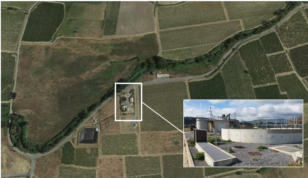
Figure 52 : Aperçu du projet de REUT de la STEP de Roquefort des Corbières (Aude) pour l'irrigation de la vigne
