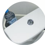
Chasse d'eau avec bouteille pour réduire la capacité
